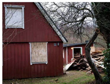
Arrendatorn har redan satt igång med att renovera.
